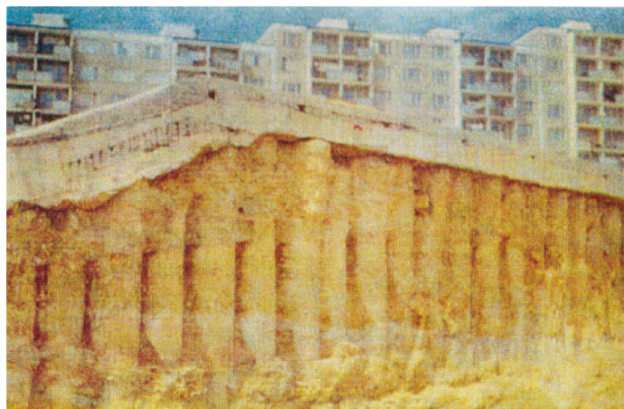
Obnažená časť pilotovej steny pod školou vo IV. okrsku.
