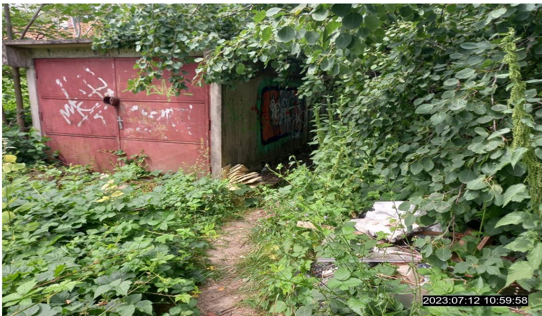
(skládka stavebného odpadu Furčianska 2, KE)
